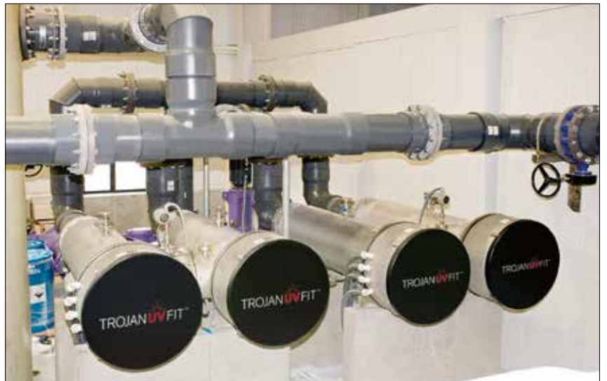
Los reactores se pueden instalar en serie o en paralelo para obtener un mejor diseño y flexibilidad en la instalación.
